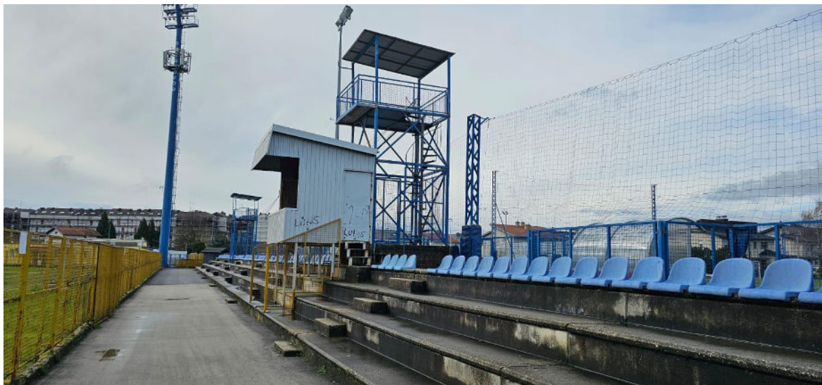
Kućica za instalacije
