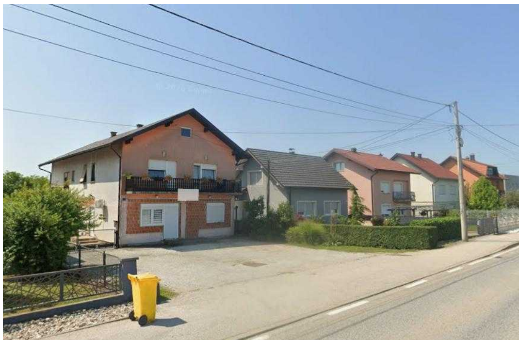
Slika 7. Naselje Šibice (građevine niske stambene gradnje za individualno stanovanje)
