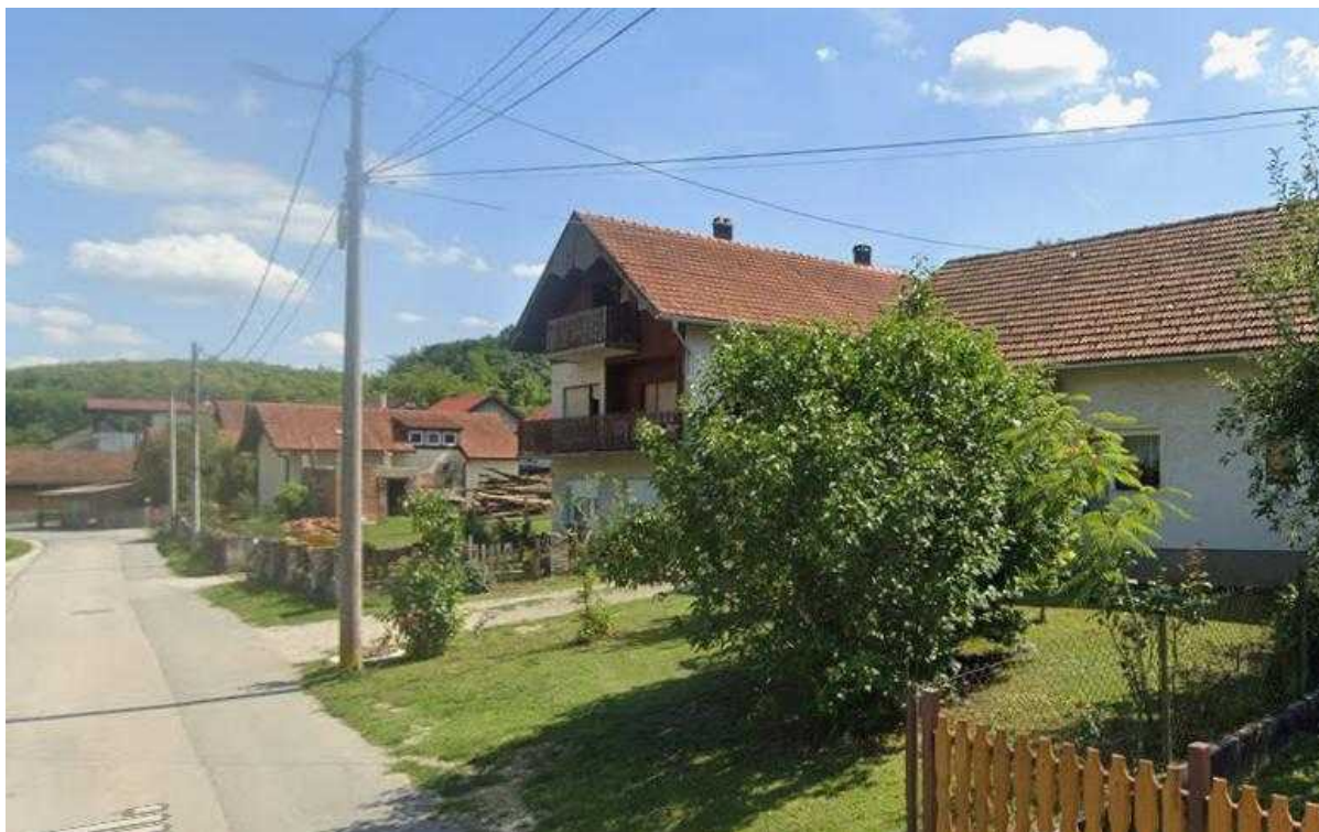
Slika 10. Kupljanovo (građevinska konstrukcija građevina)
